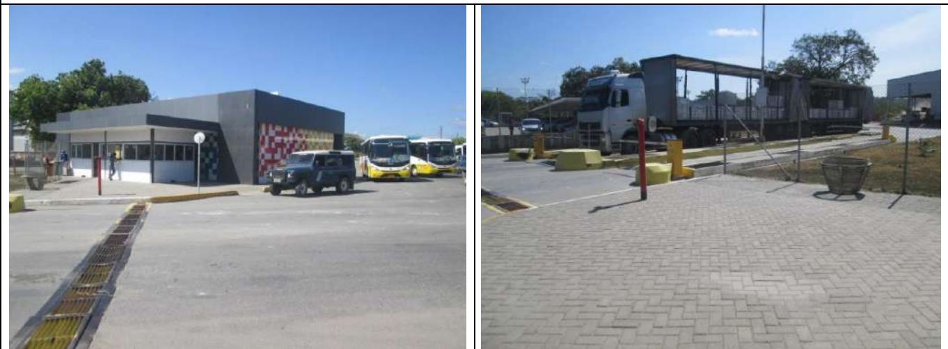
Vista da portaria e vestiário
