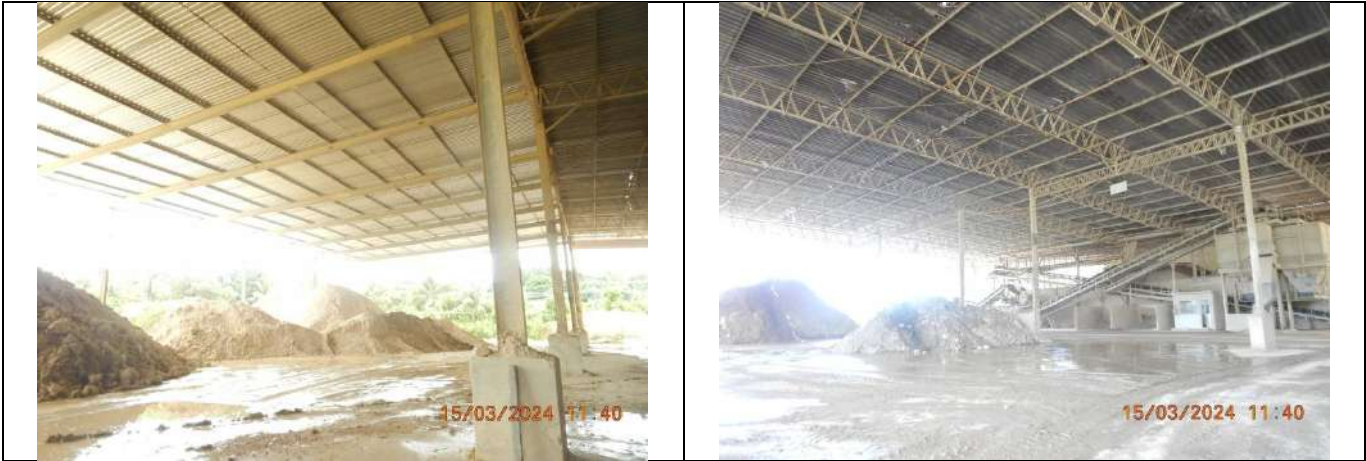
Vista do galpão de matéria prima
