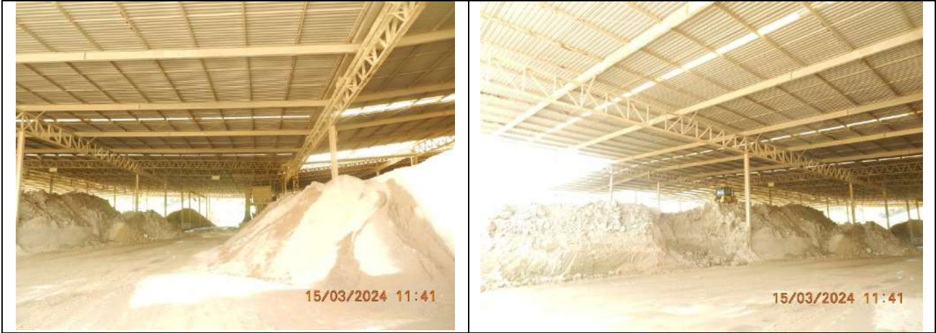
Vista do galpão de matéria prima
