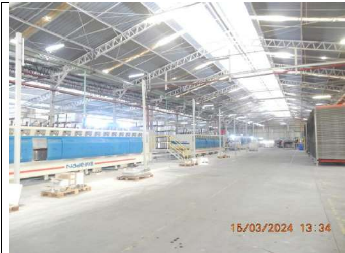
Galpão da área de polimento de piso
